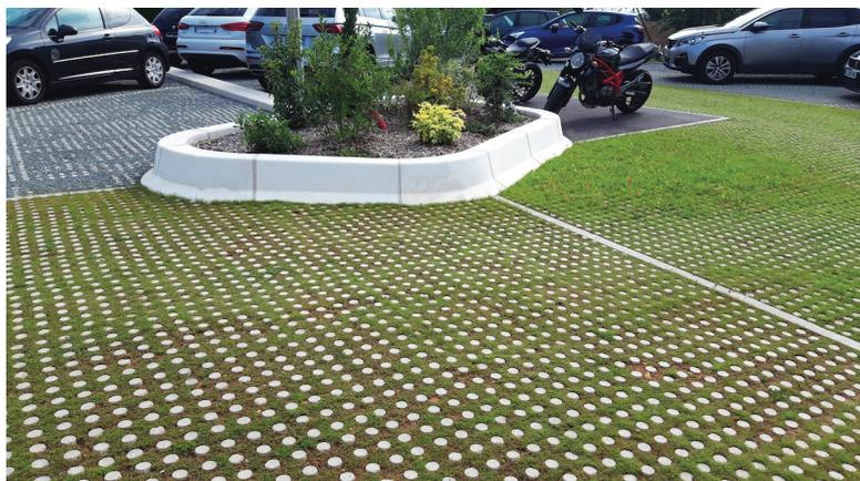
**Exemple : dalle béton végétalisée utilisée pour gérer les eaux pluviales « à la source » en les infiltrant.**
